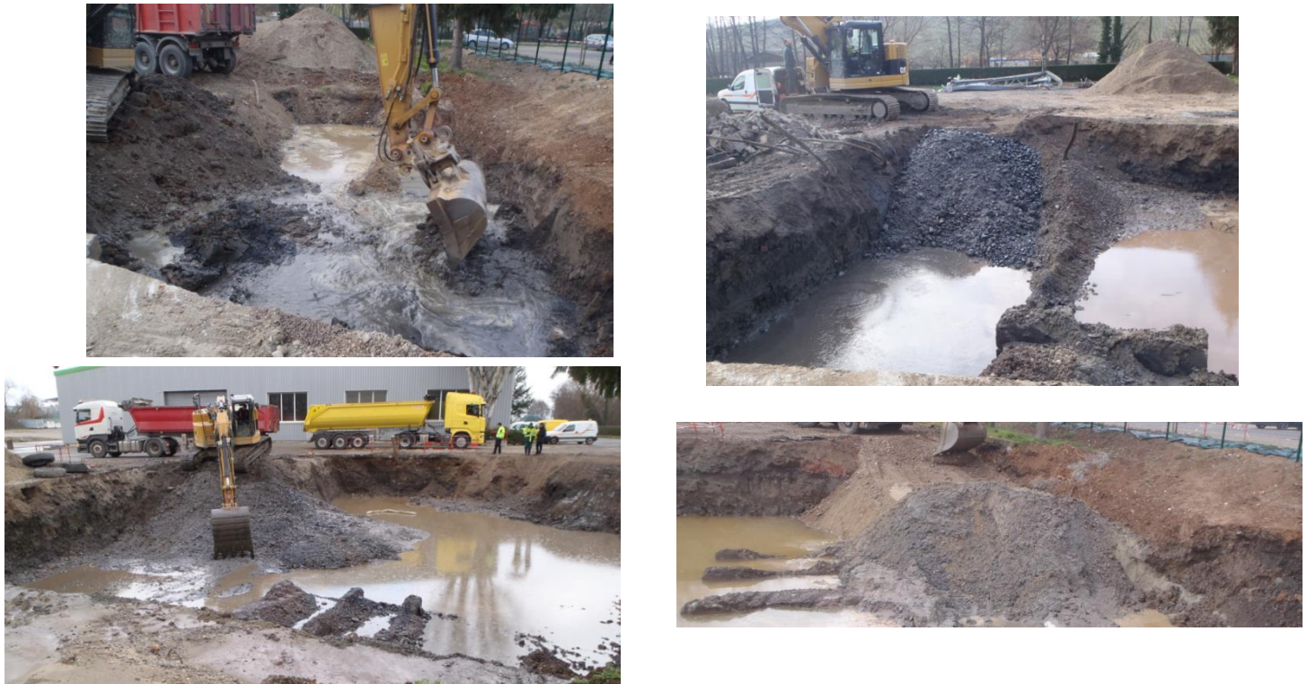
Figure 10 – Travaux d'excavation des sols les plus impactés et évacuation directe
