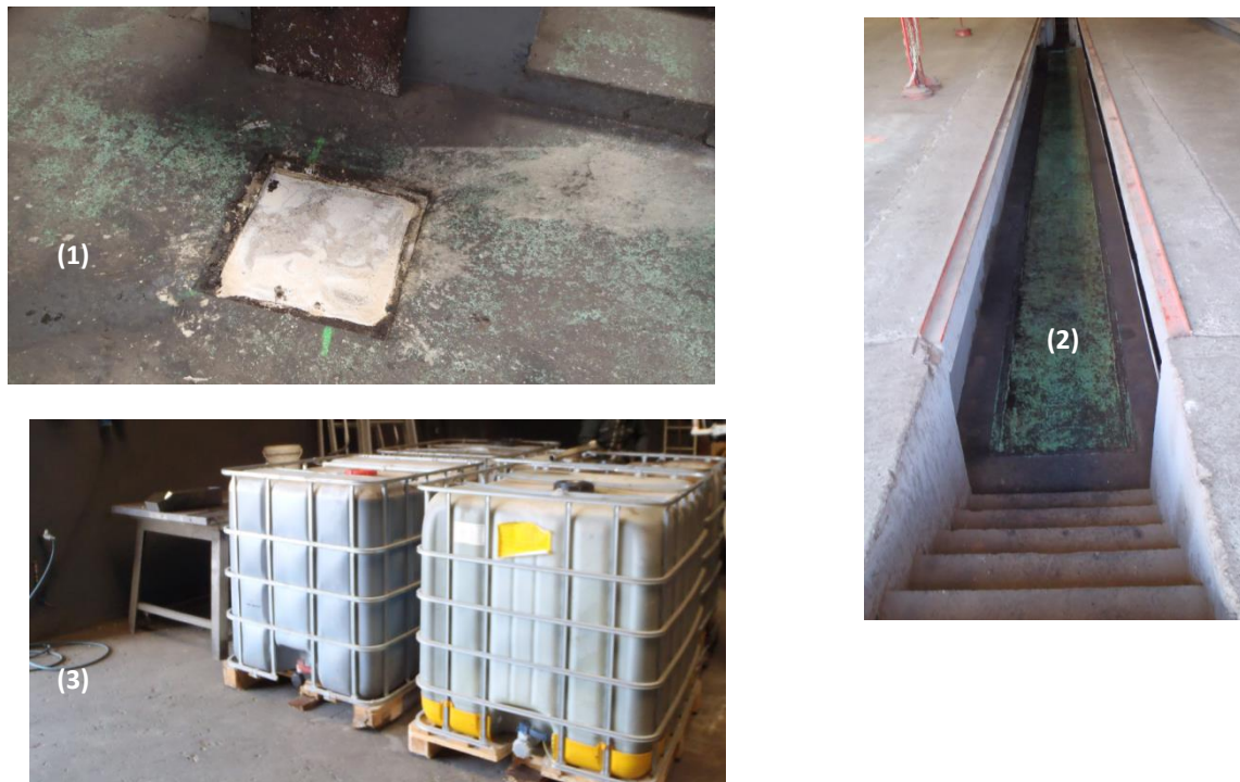
Figure 8 –Fosse d’huile usagée inertée (1) / fosse de vidange nettoyée (2) / stockage des déchets liquides avant leur élimination (3)
