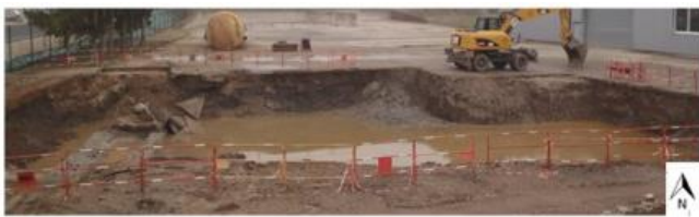
Figure 10 – Travaux d'excavation des sols les plus impactés et évacuation directe
