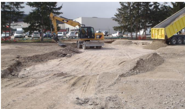
Figure 13 – Remblaiement de la fouille
