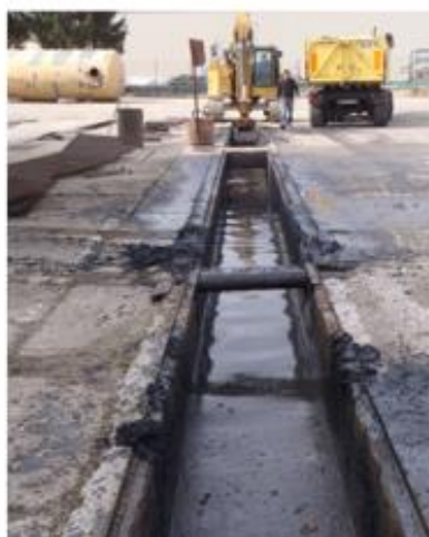
Figure 9 – Curage mécanique des boues au droit des caniveaux de l'aire de lavage
