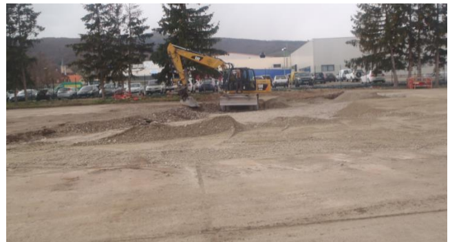
Figure 13 – Remblaiement de la fouille
